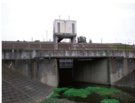
分流雨水放流渠 きよ (猪方排水樋門・駒井町 3 丁目)
