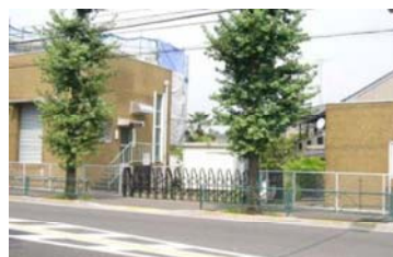
狛江(中継)ポンプ場(東和泉 1 丁目)
