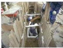
雨水管渠の整備 (漏水対策)
